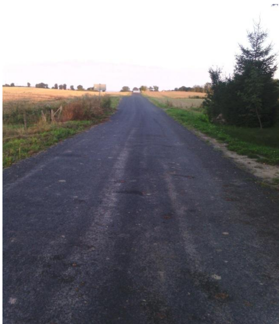
Droga gminna Mątyki-Urwisko
