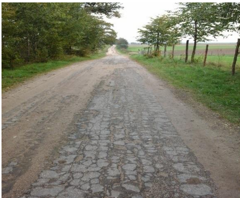
Droga powiatowa w stronę mostu Gierłoż
