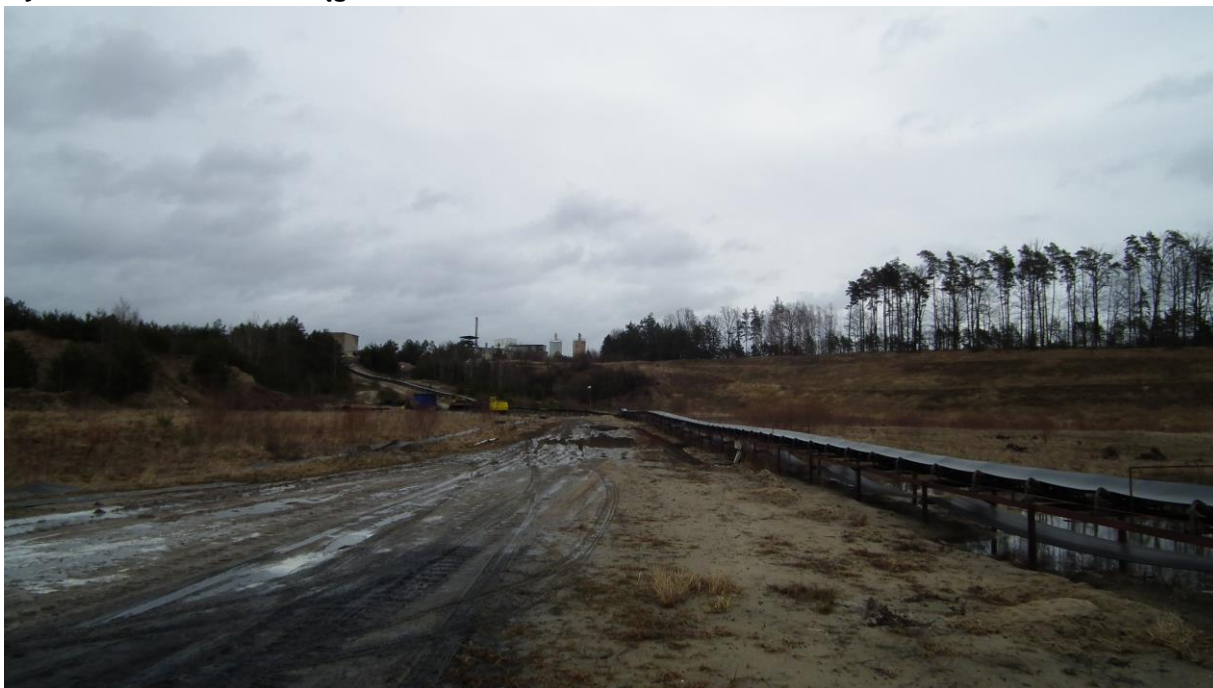
Ryc. 5 Widok na taśmociąg
