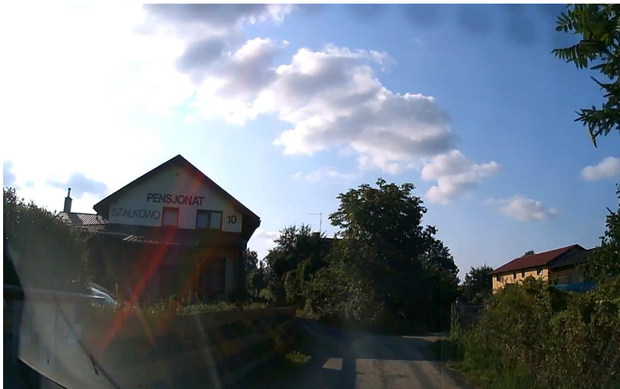
Ryc. 4 Widok na zabudowę mieszkaniowo-usługową nad Jeziorem Jeziorak w miejscowości Szalkowo
