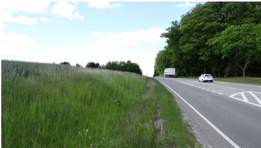
Zdj. nr 2. Obszar opracowania – obr. Rudzienie – droga krajowa nr 16.
