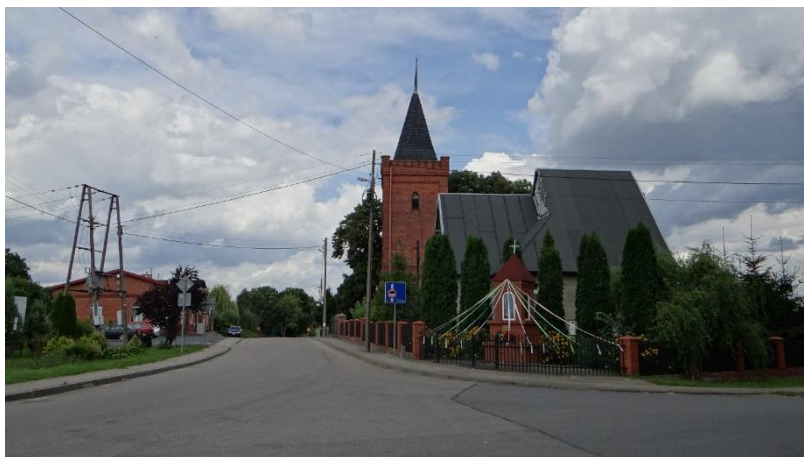
Zdj. nr 26. Obszar objęty projektem planu – zabudowa publiczna (kościół).
