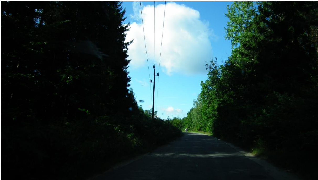
Ryc. 5 Widok na linię średniego napięcia przebiegającą nad drogą objętą planem
